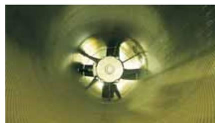
Система вытяжки воздуха 110 кВт
